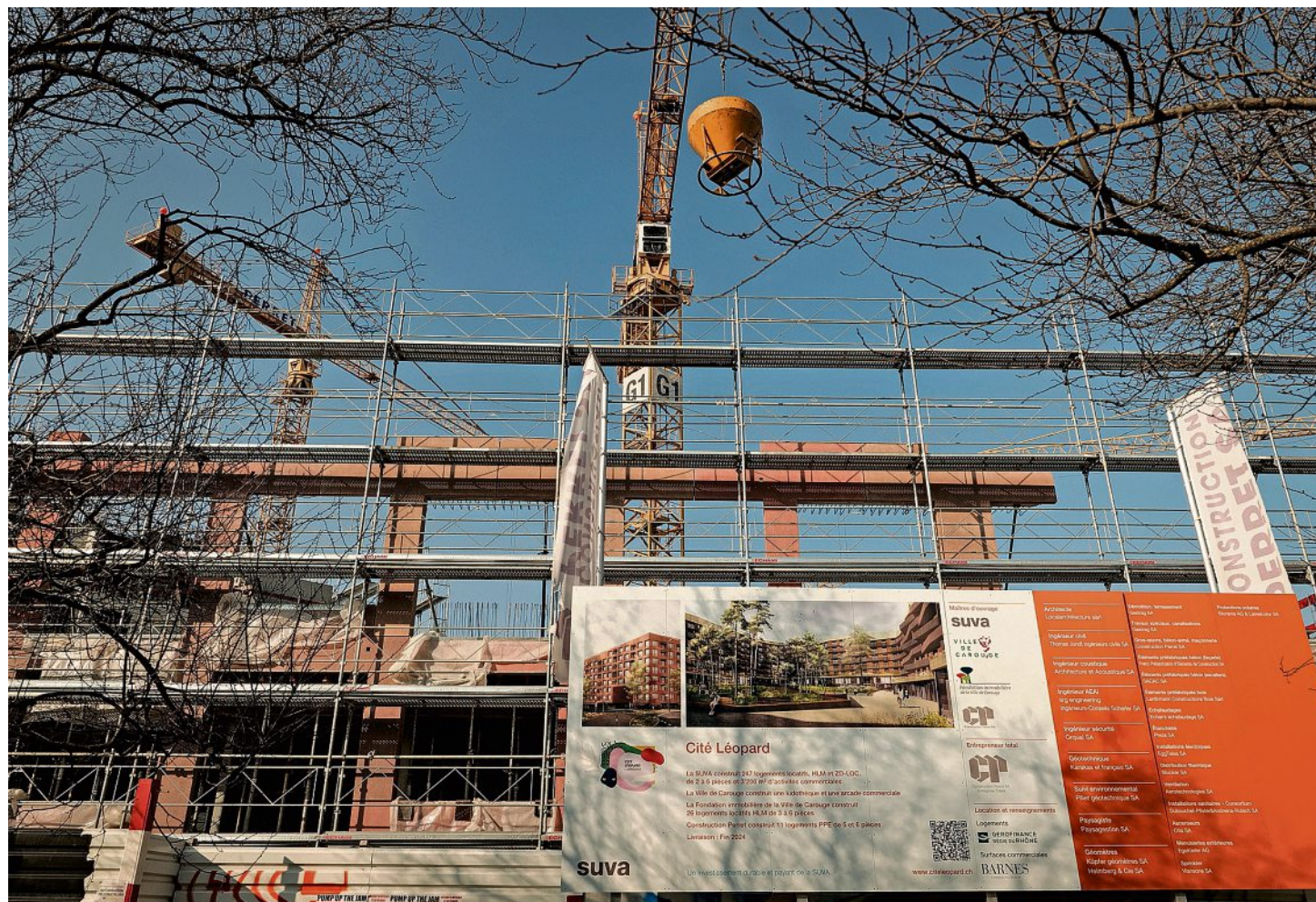
À l'angle des rues de la Fontenette et des Moraines, le complexe datait des années 50 et n'était pas assez dense. LAURENT GUIRAUD
